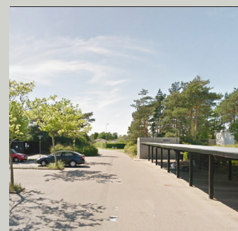
Eksisterende parkeringsarealer indrettet med carporte, teknikhuse og træærker.
