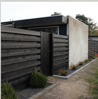
De eksisterende hegn er udført med en vandret træbeklædning, der virker som en stige, og dermed letter tyves adgang til den enkelte gårdhave.
