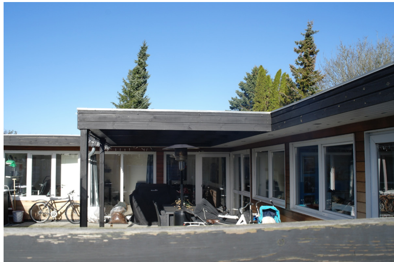
Havefacaderne består af lette malede træfacader med store vinduer eller terrassedøre. Tilbygningernes højde langs havefacaden er tilpasset sternkanten.
