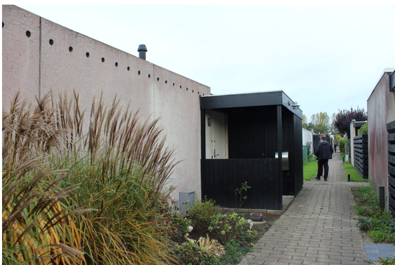
Boligbebyggelsens betonfacader og træbeklædte indgangspartier.
